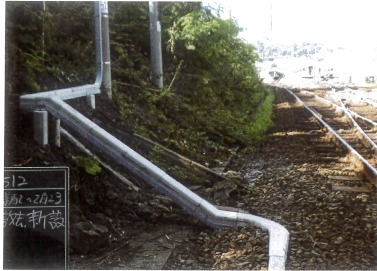
トラフ橋(組立式) 長万部駅付近
