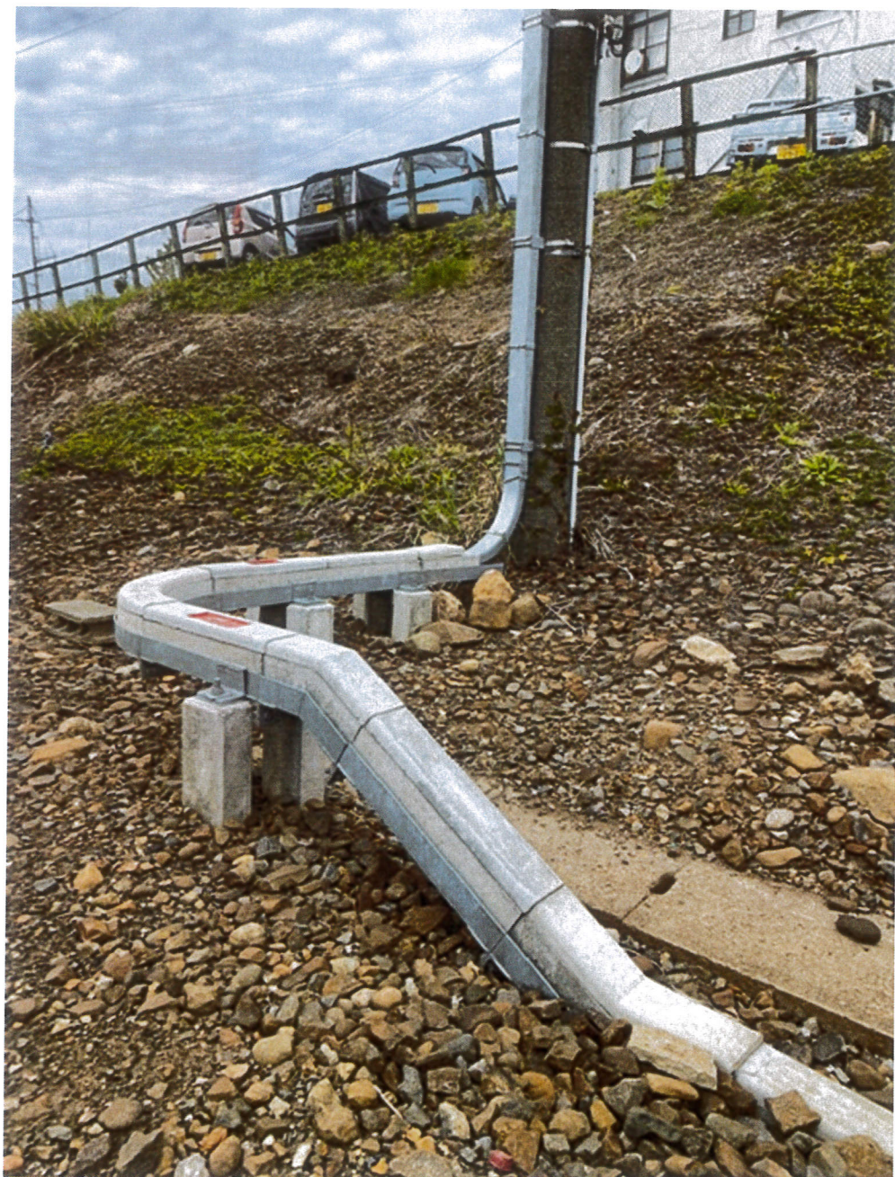
トラフ橋(組立式) 小樽駅付近
